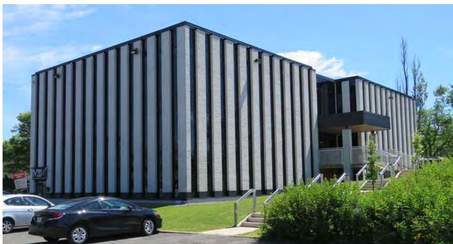
Le 1001, avenue Bégon, une des propriétés « impactées ».
