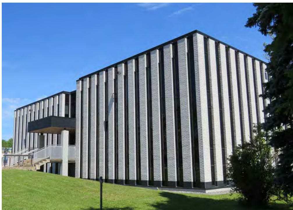
Pare-soleil en brique du 1001, avenue Bégon, des composantes hautement identitaires.
