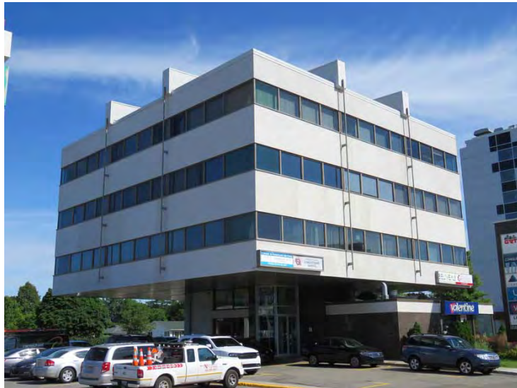
Étages aménagés en porte-à-faux de part et d'autre de la structure centrale du 2860, chemin des Quatre-Bourgeois.
