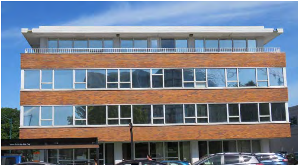
Fenêtres en bandeau, étages aménagés en porte-à-faux et balcon en partie couvert par l'avant-toit au 909-919, rue Monseigneur-Grandin.
