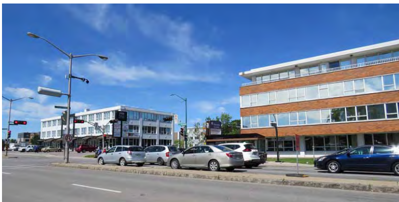
Le 2900, chemin des Quatre-Bourgeois et le 909-919, rue Monseigneur-Grandin (à gauche), deux édifices « impactés ».
