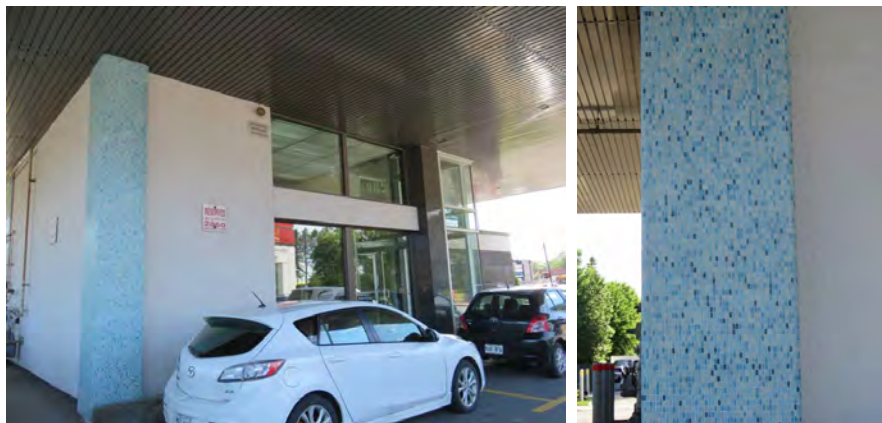
Structure centrale du 2860, chemin des Quatre-Bourgeois. Revêtement de céramique sur l'angle.
